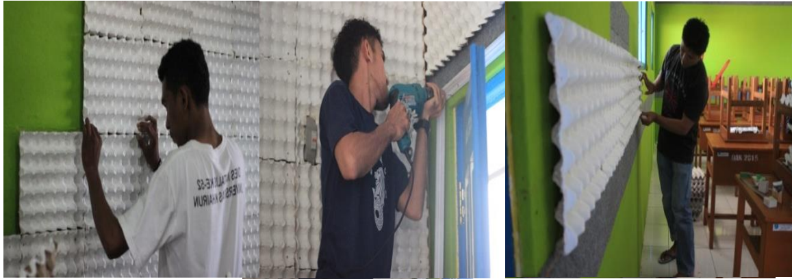
Gambar 9. Pemasangan rak telur
