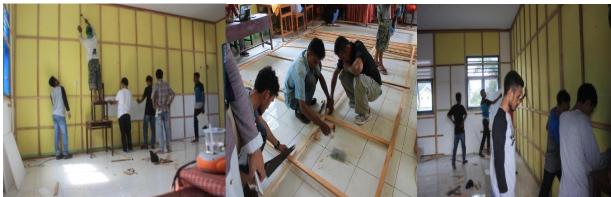
Gambar 6. Pemasangan rangka kayu
