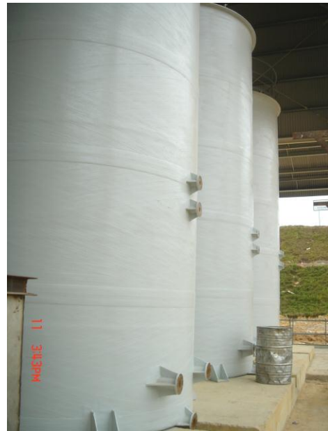
Gambar 6. Hasil rekondisi tiga unit tangki
