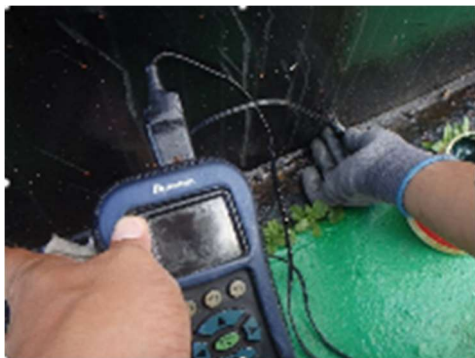
Gambar 3. Pengujian ketebalan dinding tangki dengan Ultra Sonic Test Thickness
