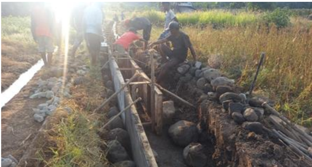
Gambar 4. Hasil kegiatan pemasangan bekisting
