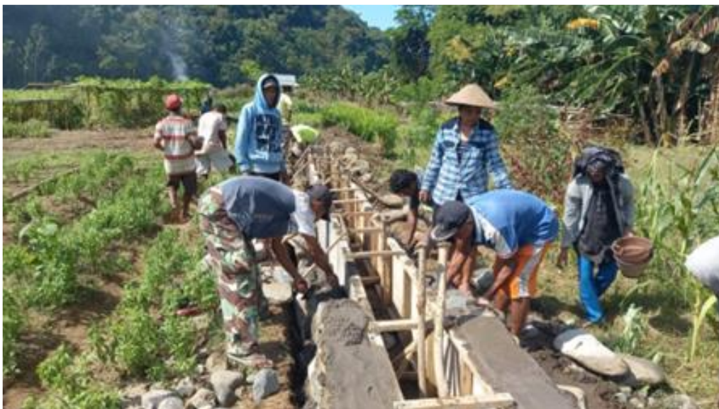
Gambar 5. Hasil tahapan kegiatan pemasangan dinding saluran
