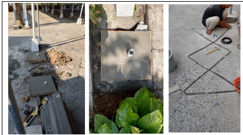
Gambar 3. Pembangunan Pondasi Barrier Gate dan Pemasangan Kabel Loop Sensor (WBS No. 3a dan 3b)
