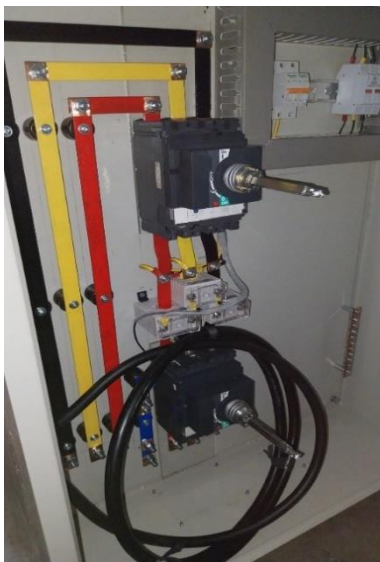
Gambar 5. Panel induk sebelum pemasangan sistem ATS ganda.
