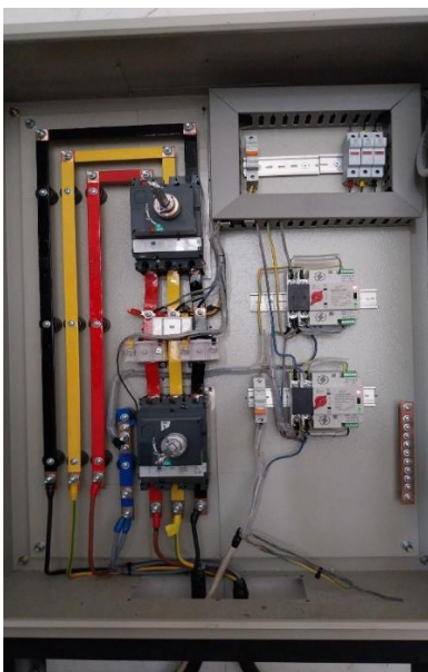
Gambar 6. Panel induk setelah pemasangan ATS ganda.
