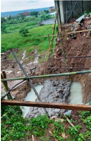
Gambar 3. Rekonstruksi Pondasi DPT
