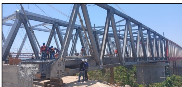
Gambar 10. Penyelesaian Erection Rangka A40 Arah Abutment 1
