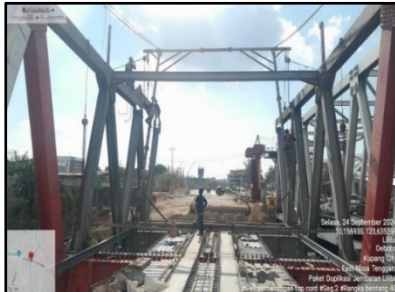
Gambar 8. Pekerjaan Rangka Baja Top Chord dan Stringer Bentang 40 m Segmen 2
