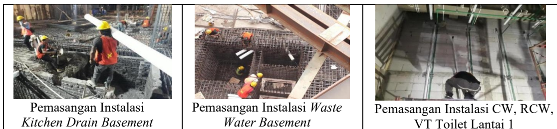
Gambar 9. Dokumentasi Pemasangan Instalasi Plumbing DP Mall Expansion
