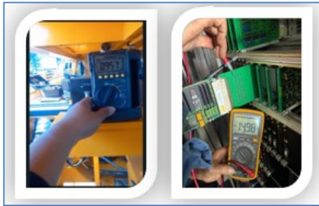
Gambar 11. Pengukuran Tegangan pada Panel
