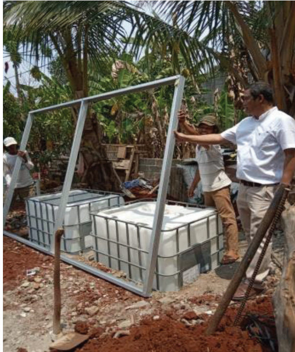
Gambar 10. Pembuatan instalasi pipa hidroponik
