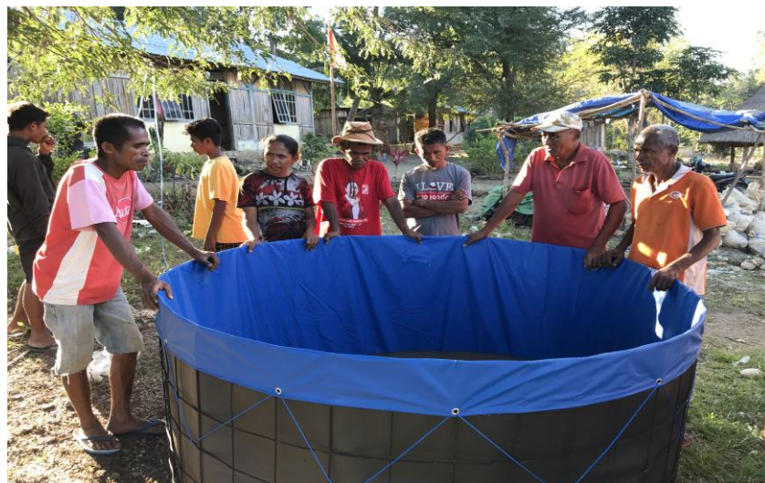
Gambar 5. Pemasangan kolam lele Bioflok
