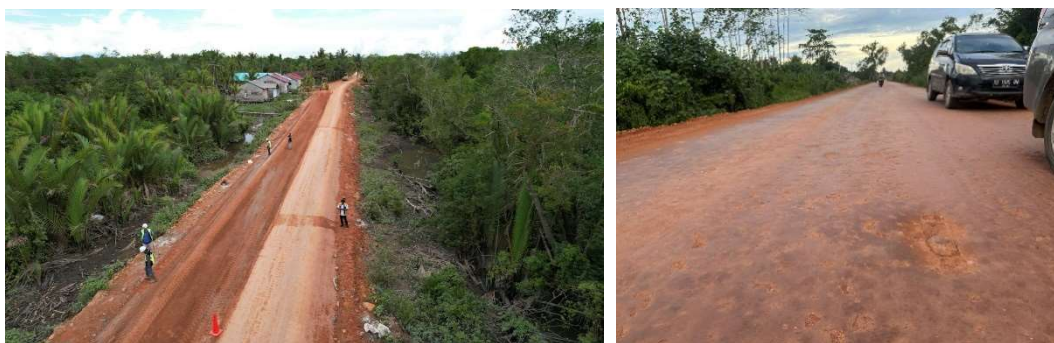
Gambar 10. Hasil Akhir Setelah Perbaikan dengan Metode CTSB
