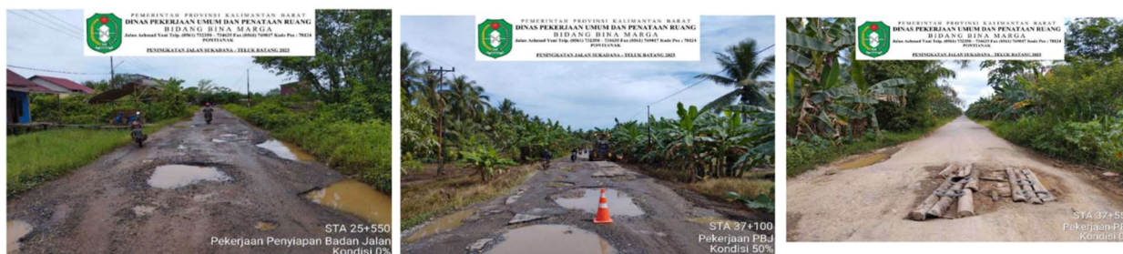
Gambar 4. Contoh Kerusakan Jalan Eksisting
