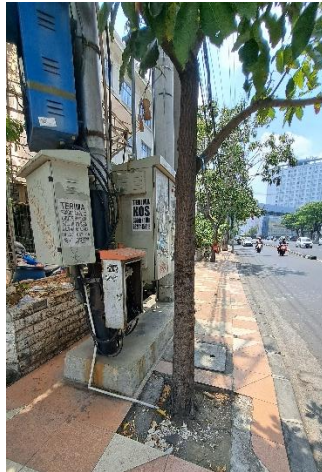
Gambar 5. Kondisi Fasilitas Pejalan Kaki (Rute 4)
