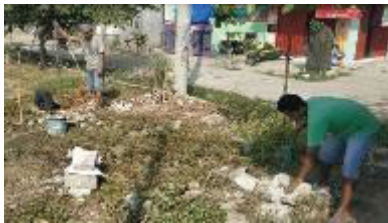
1. Penggalian lubang untuk fondasi tower triangle .
