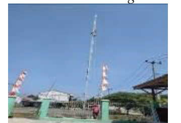
6. Tower triangle siap digunakan.
