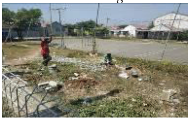
4. Persiapan pemasangan tower triangle .
