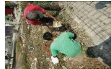
3. Pemasangan fondasi tali sink tower triangle .
