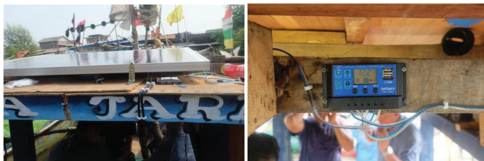
Gambar 3. Pemasangan Komponen Panel Surya
